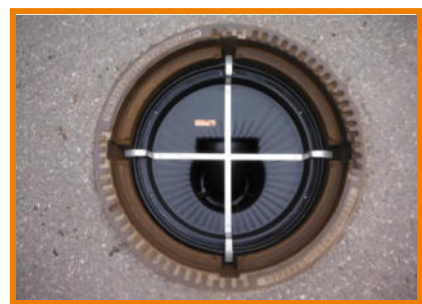
Fremdwasserverschluss-System FRK-4 in Schacht eingebaut
