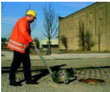
Heranfahren an Schachtöffnung
