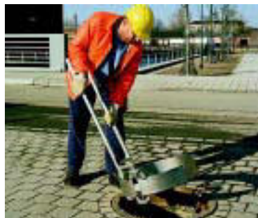
Einsetzen in Schachtöffnung
