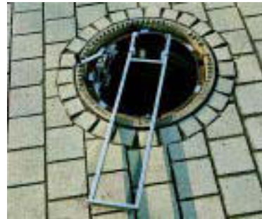
provisorische Schachtabdeckung
