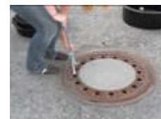
Schachtabdeckung mit Schachtdelckelheber einsetzen.
