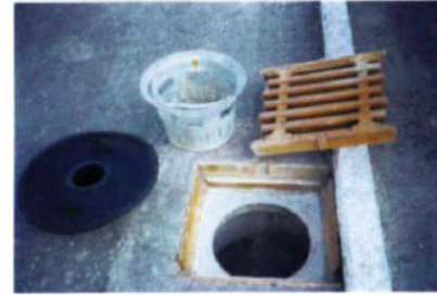
Deckel und Schmutzfänger entfernen
