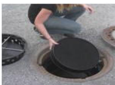
coalsi ®-Hybridaktivkohlematte zusammen mit dem Siphon einsetzen.
