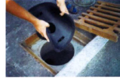
Flexiblen Kunststoffeinsatz leicht durchbiegen
