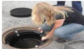
coalsi ®-Grundkörper einsetzen.
