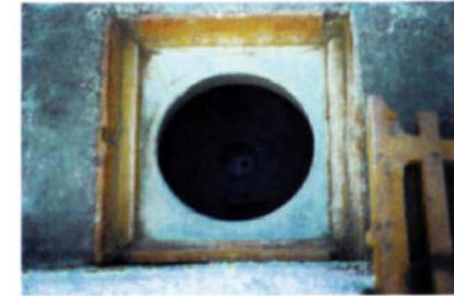
- Gassperre richtig eingesetzt
