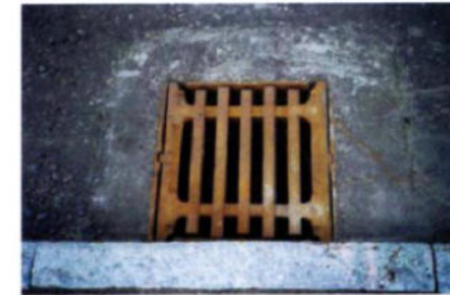
Deckel des Regenwasserablaufes schließen - fertig
