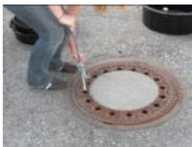
Schachtabdeckung mit Deckelheber entfernen.
