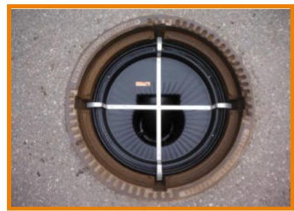
Fremdwasserverschluss-System FRK-4 in Schacht eingebaut
