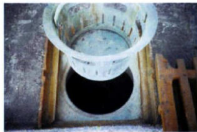
- Schmutzfänger einsetzen
